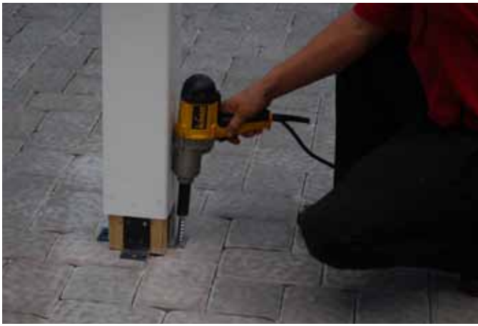
Use (4) Concrete Lags per Post.
